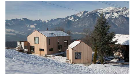
Minimalistisches Atelier und Wohnhaus inmitten grandioser Schweizer Landschaft. / Atelier minimaliste et habitation au milieu d'un paysage suisse grandiose.
